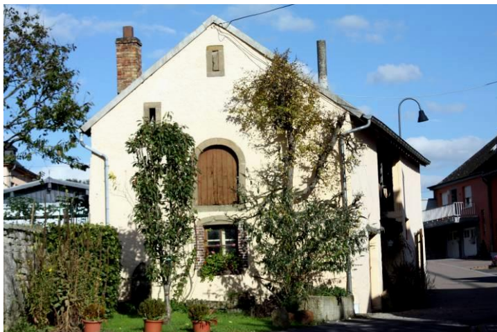
Reisdorf – 9, route de la Sûre – Annexe Nord
